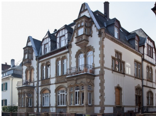
Abbildung 32 - große aber nicht bodentiefe Öffnungen, Seitenrisalite, horizontale Bänderungen, Fenstereinfassungen - Erwin-Rohde-Straße Quelle Denkmaltopografie
