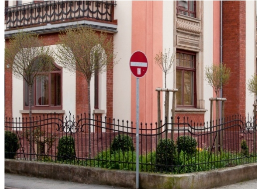
Abbildung 15 – ornamentale vertikal betonte Einfriedung mit Sockel ohne Pfeiler, Weberstraße, Quelle Stadt Heidelberg
