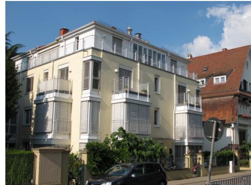
Abbildung 37 - Übereckverglasungen (raumhoch) und Staffelgeschoß sind ortsuntypisch Roonstraße Quelle Stadt Heidelberg
