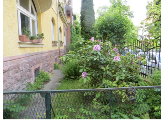
Abbildung 8 - gut erhaltene grüne Vorgartenzone mit gründerzeitlicher schmiedeeiserner Einfriedung auf Sandsteinsockel, Kußmaulstraße, Quelle Büro Merz
