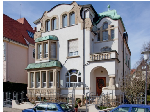
Abbildung 27 - Jugendstilgebäude mit ornamentaler Einfriedung, bewegtem Fassadenbild durch Vor- und Rücksprünge, unterschiedlichste Fensterformen, schmückende Details, Roonstraße, Quelle Denkmaltopografie
