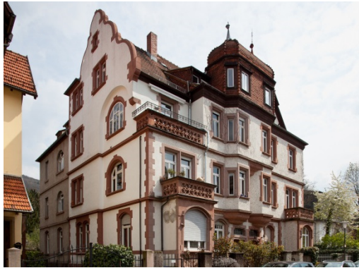
Abbildung 26 - spätklassizistischer Putzbau mit Sandstein Elementen, Erkern, Risaliten, Eck- und Fenstereinfassungen, Schaugiebel, Türmchen und Balkonen zur Fassadengliederung Erwin-Rohde-Straße, Quelle Denkmaltopografie
