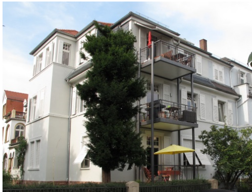
Abbildung 13 – Balkonturm, abgestützt und über alle Geschosse geführt in frei zu haltender Vorgartenzone Werderplatz, Quelle Stadt Heidelberg
