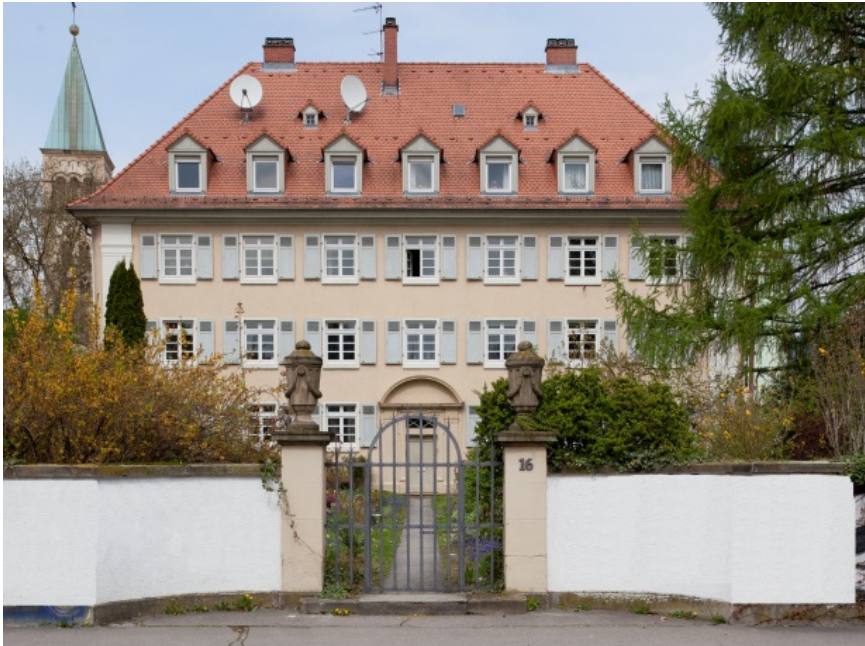
Abbildung 46 - Foto der Mönchhofstraße 16, ehem. Lehrerwohnhaus - Quelle Denkmaltopografie
