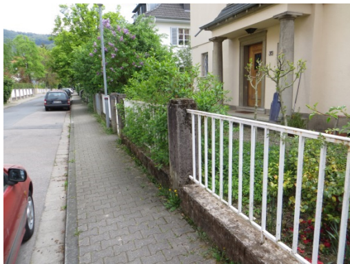
Abbildung 16 - schlichte vertikal betonte Einfriedung aus den 1920-er / 30-er Jahren mit Sockel und Pfeiler Moltkestraße, Quelle Stadt Heidelberg
