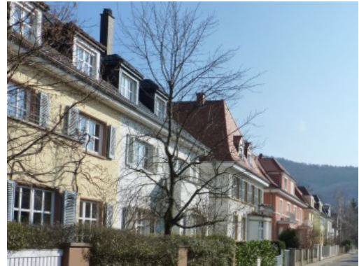
Abbildung 42 - Wohngebäude der 20-er und 30-er Jahre in der Moltkestraße mit Einzelgauben Quelle Stadt Heidelberg
