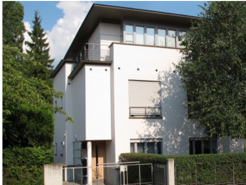
Abbildung 34 - quadratische Öffnungen ohne Fassung, bodentiefe Fensterformate Keplerstraße, Quelle Stadt Heidelberg
