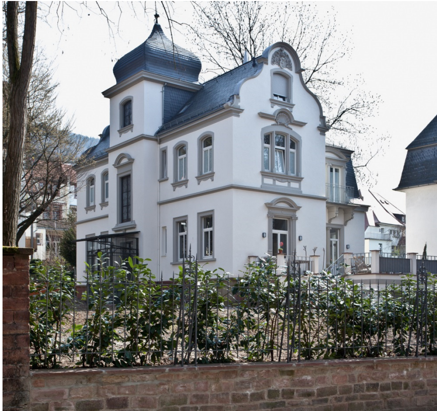
Abbildung 55 - Foto Hainsbachweg 2/1 - Quelle Denkmaltopografie
