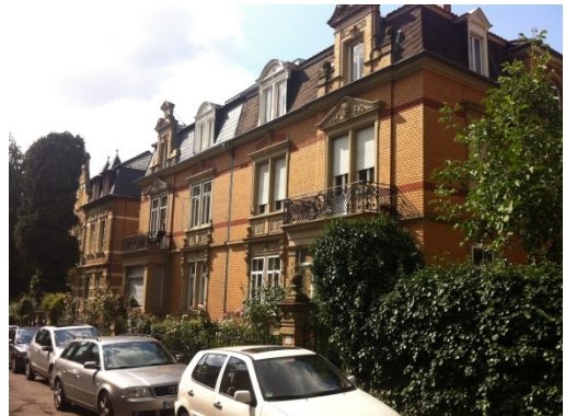
Abbildung 29 - gründerzeitliches Reihenhauses mit Klinkerfassade und Sandsteinelementen, Erkern und Balkonen Blumenthalstraße - Quelle Stadt Heidelberg
