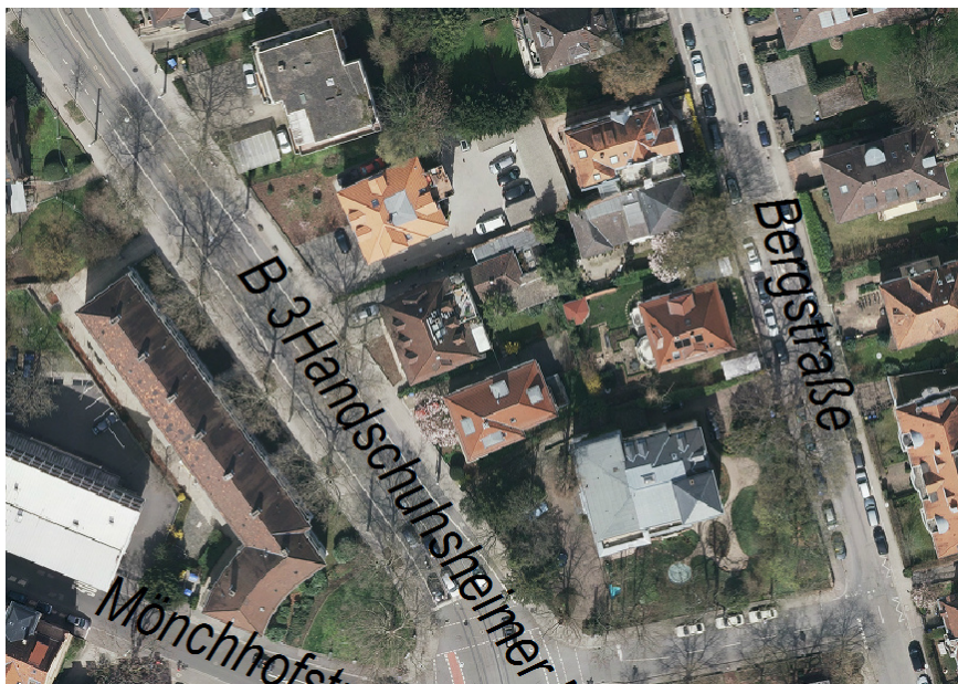
Abbildung 53 - Luftaufnahme von Handschuhsheimer Landstraße 2 und Bergstraße 29a - Quelle GTIS der Stadt Heidelberg
